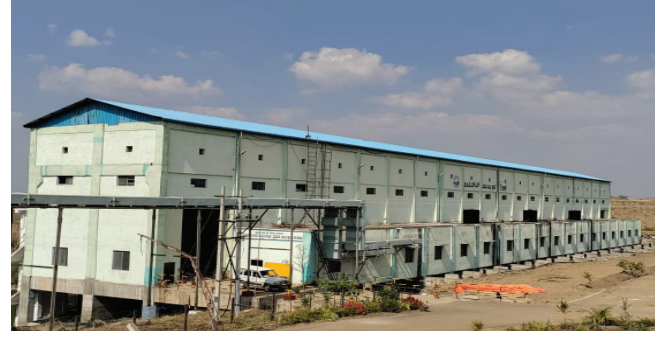
ಮುಳವಾಡ ಏತ ನೀರಾವರಿ ಯೋಜನೆ ಹಂತ-3ರಡಿ ಹನುಮಾಪುರ ಮುಖ್ಯ ಸ್ಥಾವರ Hanumapur Head Work under Mulawad Lift Irrigation Scheme Stage-III
