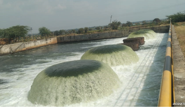
ಬಳೂತಿ ಮುಖ್ಯ ಸ್ಥಾವರದ ಡೆಲಿವರಿ ಚೇಂಬರ್ Delivery Chamber of Baluti Head Work
